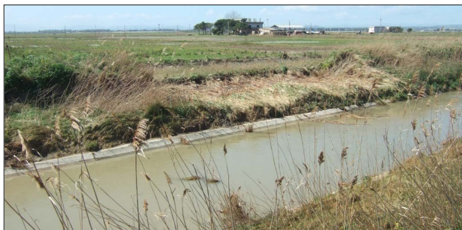
Figura 6 - Vista della breccia dell' argine destro del collettore della Marinella situata a monte della paratoia di scarico delle acque alte del terzo colatore della Marinella nello stesso collettore della Marinella.
