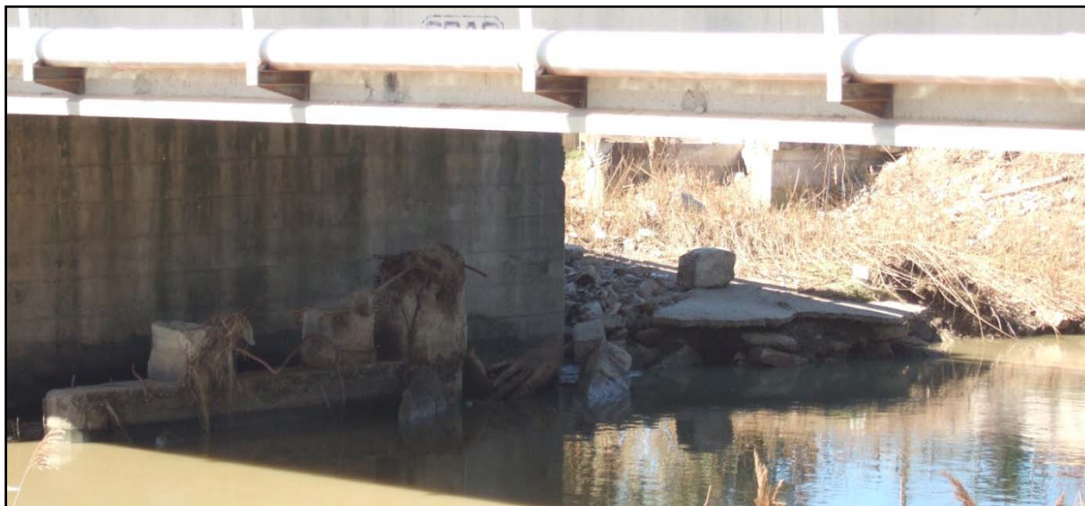
Figura 21: Vista della pila destra del vecchio attraversamento di viale Ionio situato al di sotto di quello attuale
