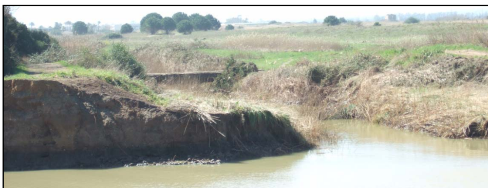
Figura 13: Particolare della confluenza del canale Salinella nel torrente Galaso
