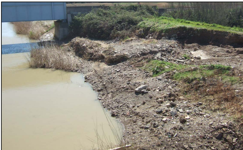
Figura 18: Vista della sponda destra del torrente Galaso nel tratto compreso tra l' attraversamento di viale Ionio e quello ferroviario in cui si nota il deposito di sedimenti (tratto già riparato dall' Amministrazione Comunale con altri fondi)
