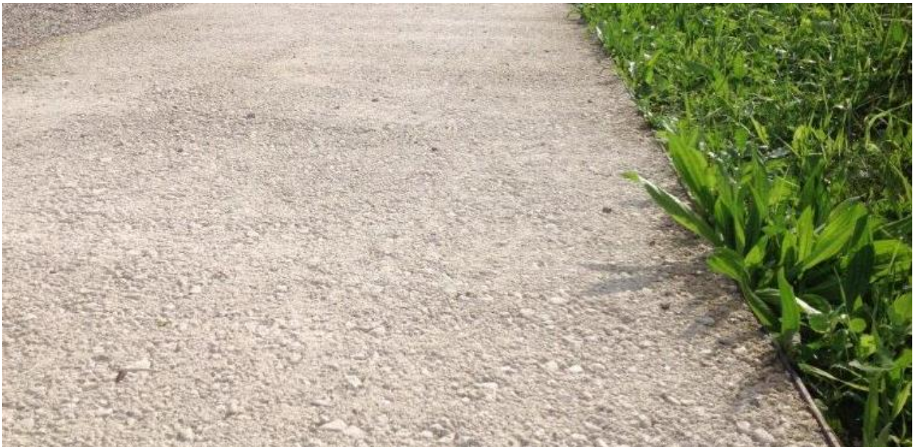
Fig. 12 - Esempio di pavimentazione a sasso lavato
