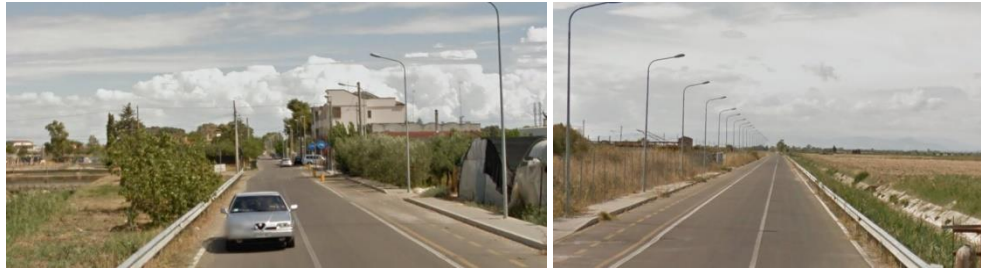
Via Contrada Marinella _ Marina di Ginosa _ percorso di Bicalta n. 14
