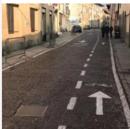
Sezione tipo: Corsie ciclabili per doppio senso ciclabile
