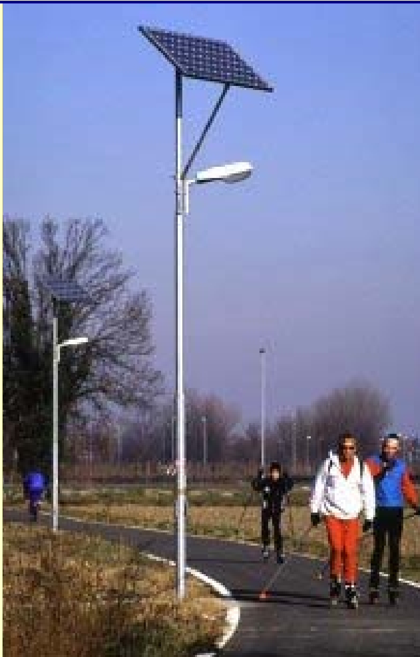
FOTO 8 – Lampioni a pannelli solari su piste ciclo-pedonali
