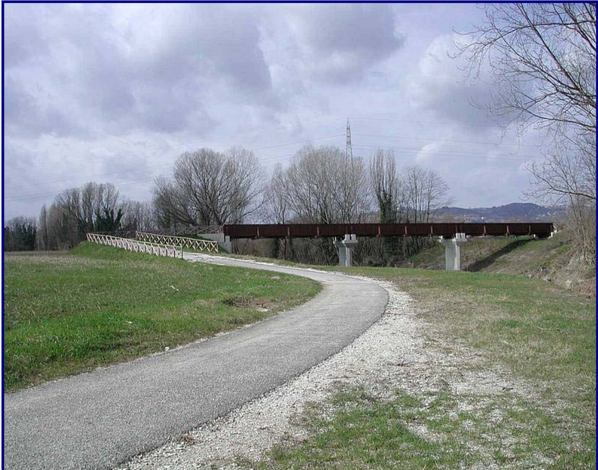
FOTO 10 - Pista ciclabile rifinita con semipenetrazione di emulsione bituminosa
