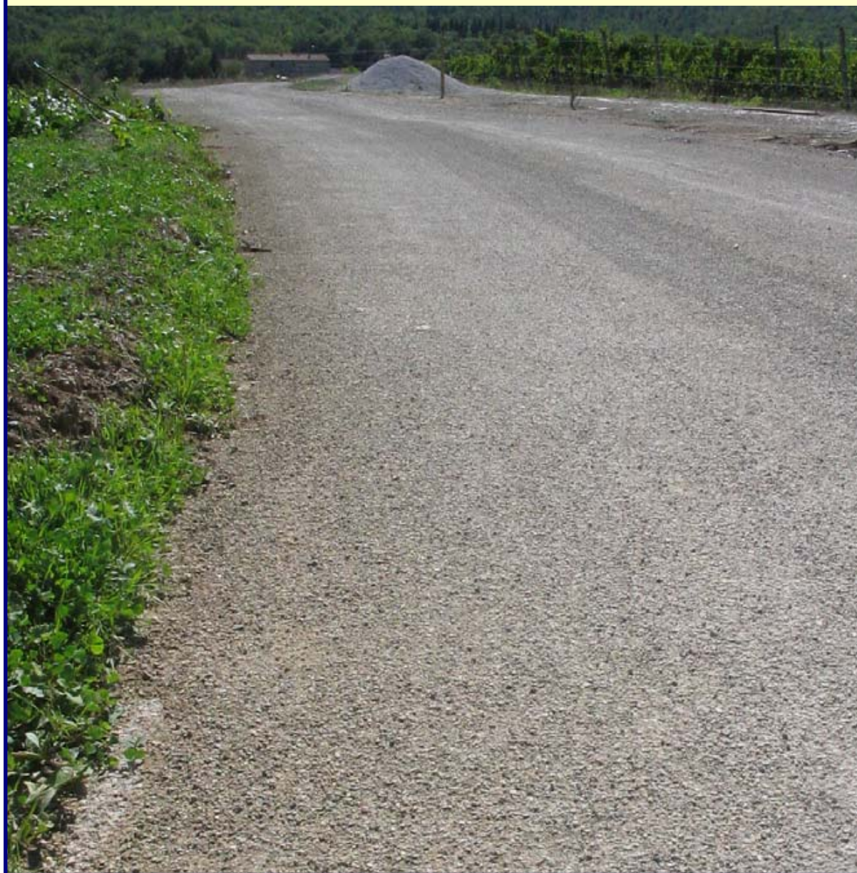
FOTO 15 –Strada vicinale esistente trattata con stabilizzato tipo “Colorbit” o similari
