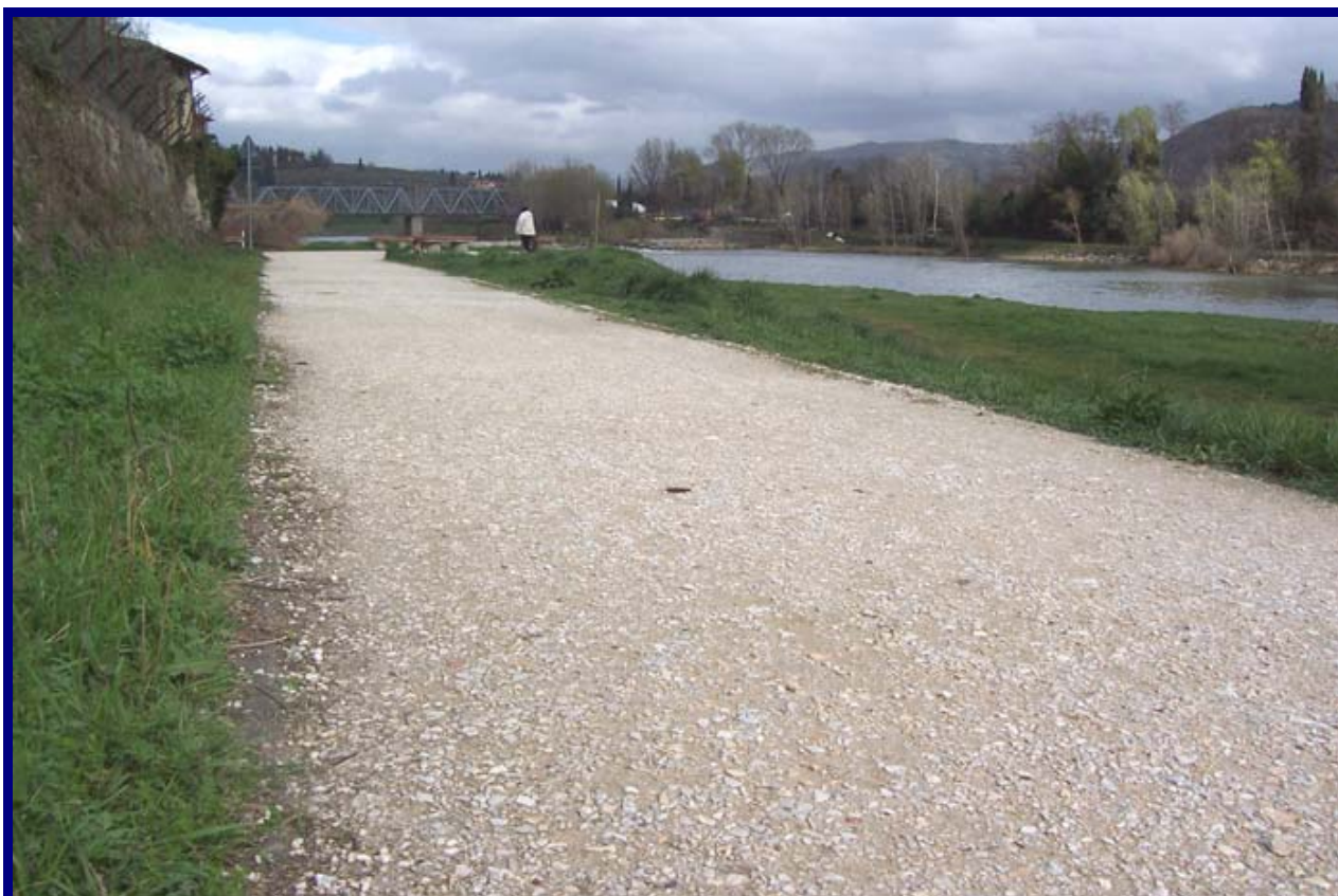
FOTO 13 - Pista ciclabile in stabilizzato di cava
