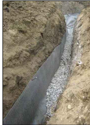
Figura 1: Esempio trincea drenante
