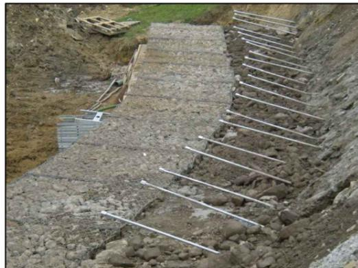
Figura 10: Esempio chiodatura
