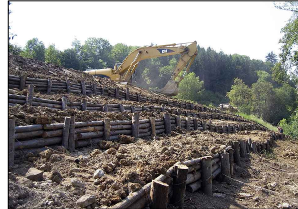
Figura 3: Esempio viminate
