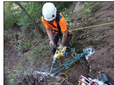
Figura 6: Esempio dettaglio esecutivo disaggio
