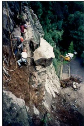
Figura 5: Esempio disgaggio
