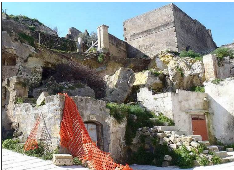
Fig. 14: Crollo in Via San Giovanni (situazione pre e post crollo)
