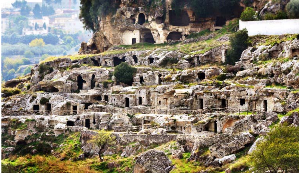
Fig. 3: Gravina di Ginosa – Villaggio Rivolta
