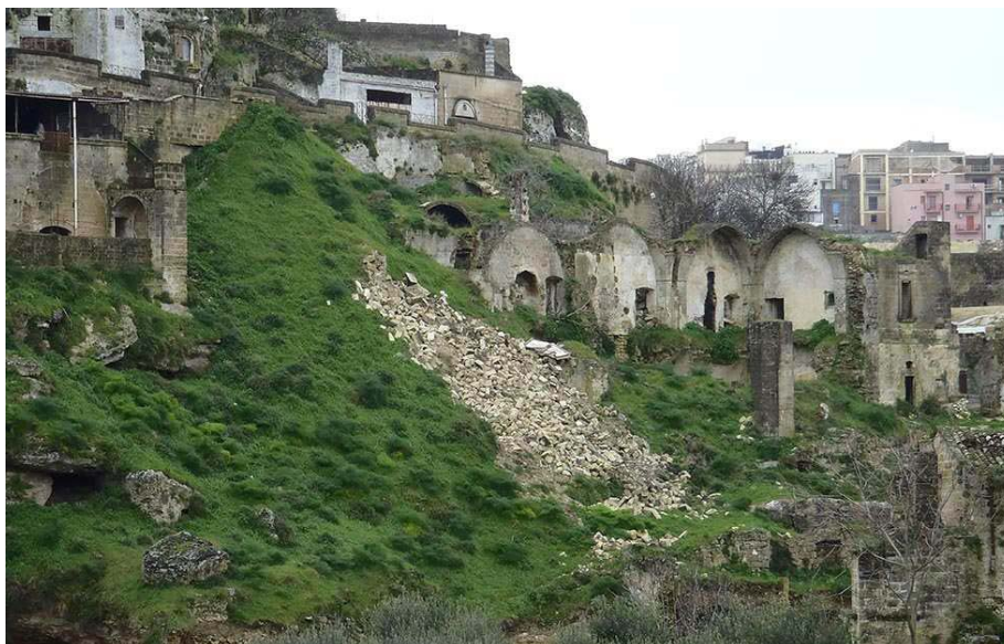
Fig. 12: Rudere crollato a valle di Via Matrice (Rapporto CNR-IRPI 2014)
