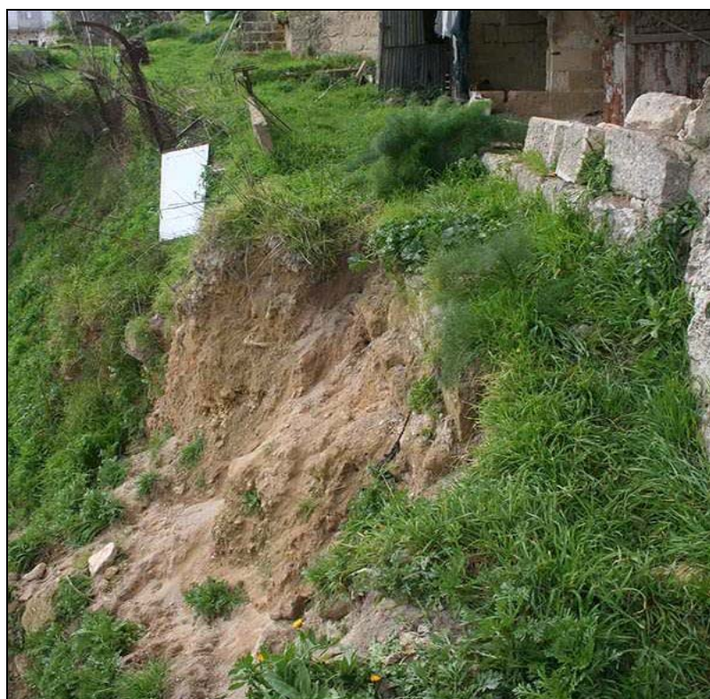
Fig. 13: Scorrimento rotazionale sul pianoro del Castello (Rapporto CNR-IRPI 2014)
