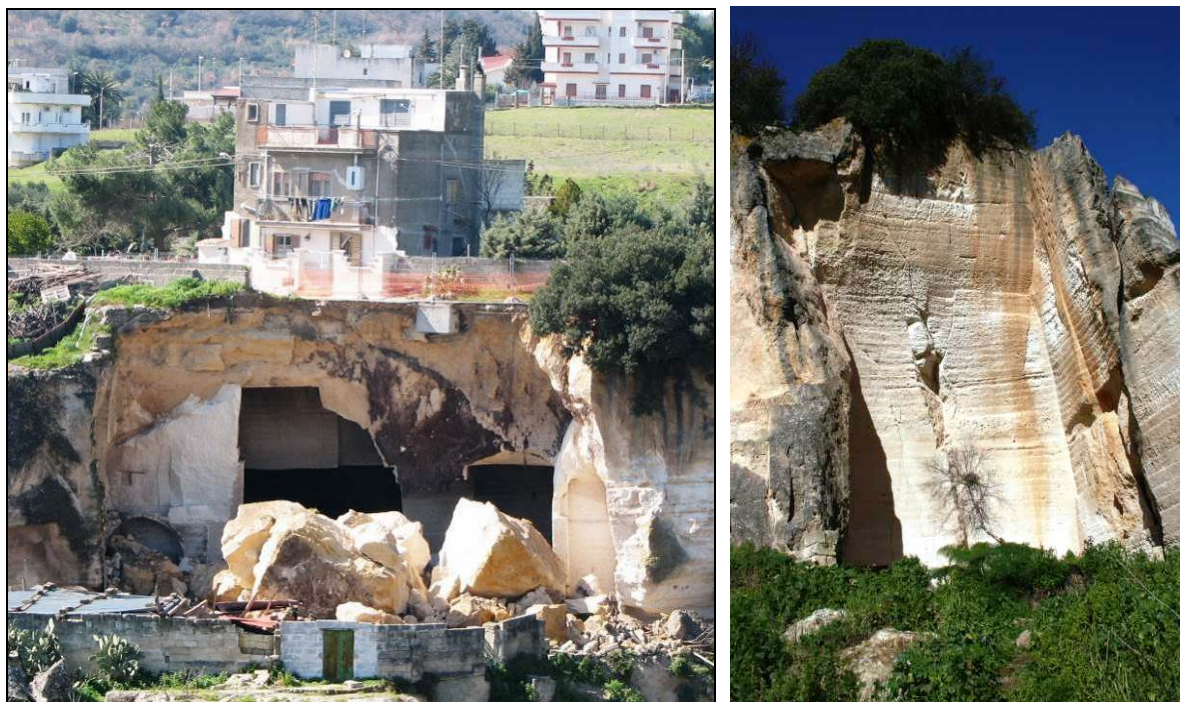
Fig. 7: Dissesti su Via Pescarella: crollo ingresso cava (sinistra) - fratturazione ammasso roccioso (destra)
