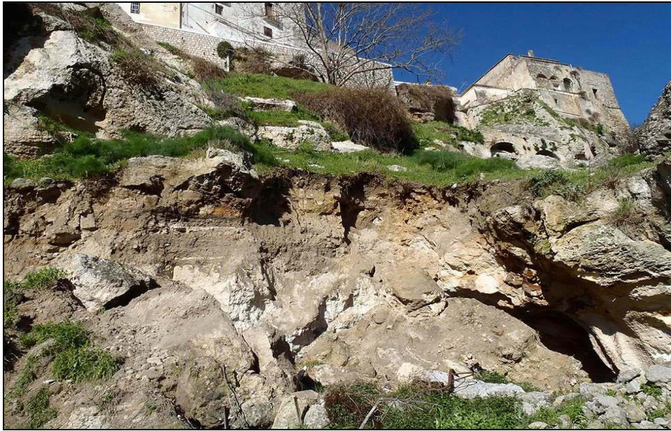
Fig. 16: Ginosa, villaggio Rivolta: sprofondamento connesso a cavità antropica (rapporto CNR IRPI, 2014)
