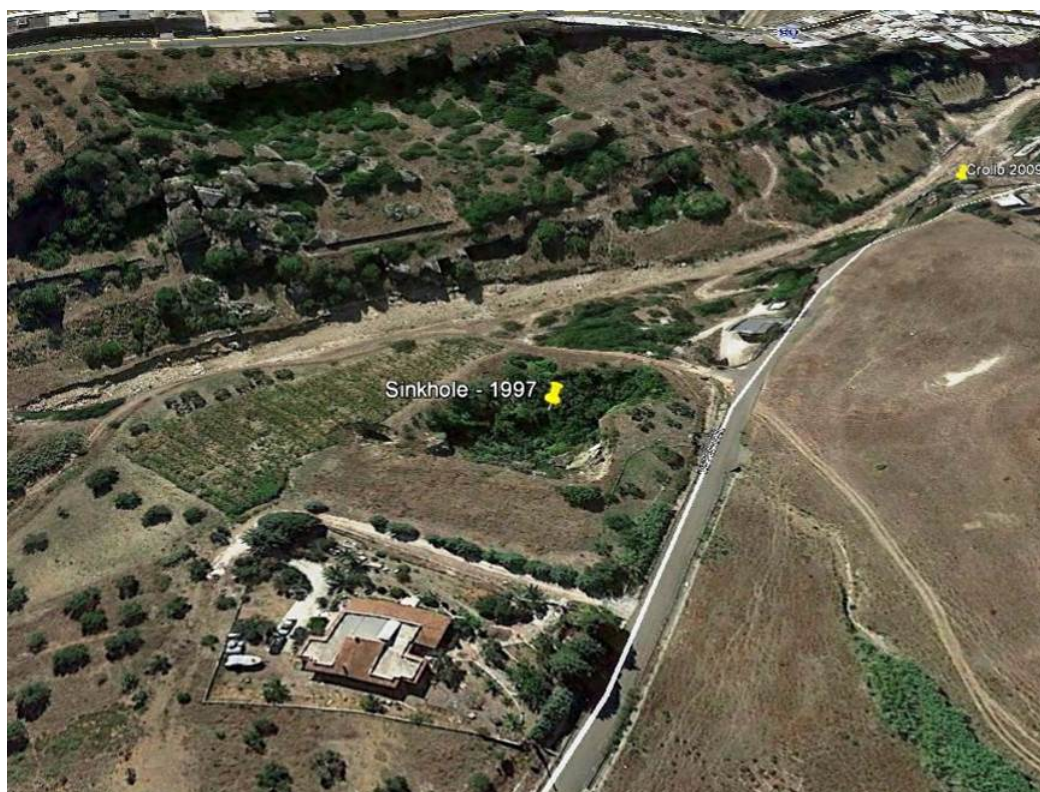
Fig. 8: Sprofondamento piano campagna in Via Pescarella (ortofoto Google Earth)
