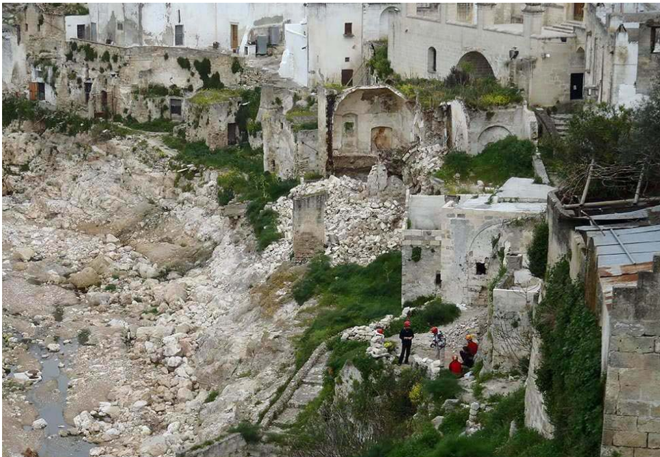
Fig. 17: Rudere crollato nei pressi della Chiesa Matrice (sito E in fig.16)
