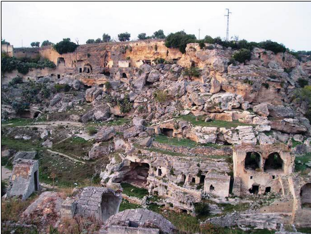
Fig. 9: Sponda sinistra della gravina di Ginosa, il Casale. Crollo del 1857
