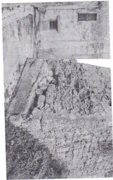
Foto particolare base pilastro ponte
